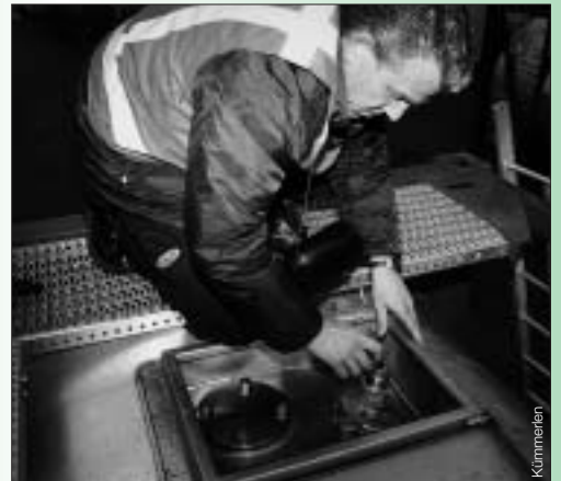
Arbeiten auf Tankcontainern sind riskant, wenn der Seitenschutz fehlt.
